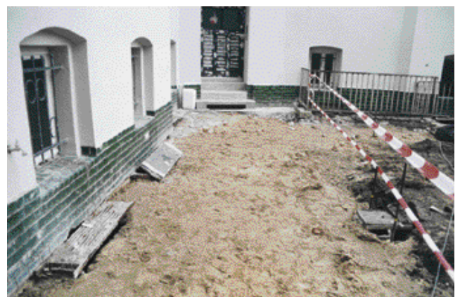
Bild 3: Auch während der Bauphase muss der Hauszugang immer gewährleistet sein.
