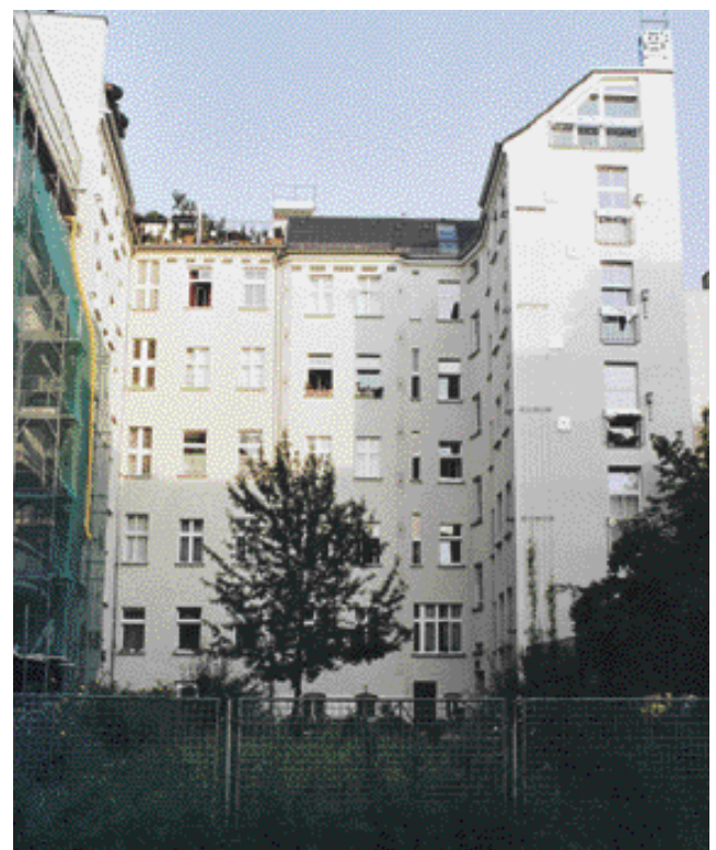
Bild 8: Seitenflügel und Hinterhaus nach der Sanierung, im Vordergrund der 2. Bauabschnitt, der nach den Fassadenarbeiten im Herbst begonnen wird.
