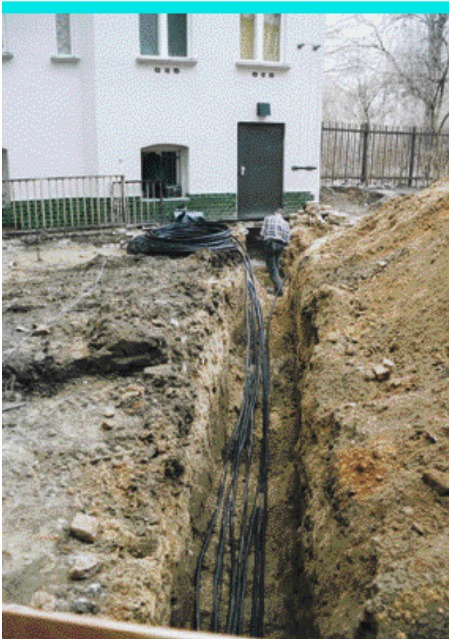
Bild 4: Auf engstem Raum arbeiten mehrere Gewerke: Verlegung der Telekommunikationskabel.
