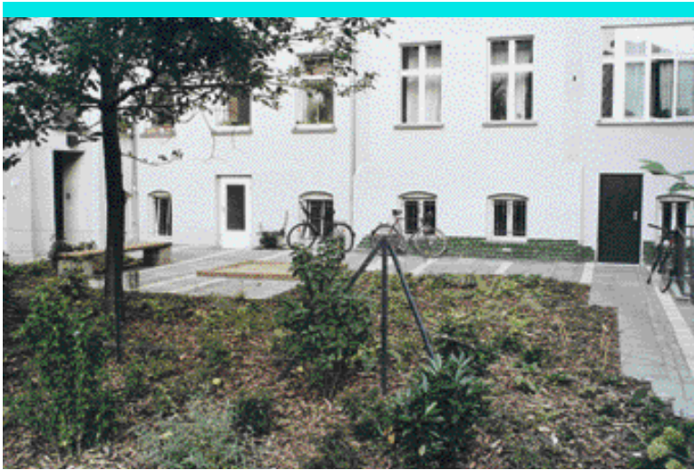
Bild 6: Der fertiggestellte Innenhof, vom Nachbargrundstück aus gesehen. Aus verwaltungstechnischen Gründen trennt ein Zaun die Grundstücke.
